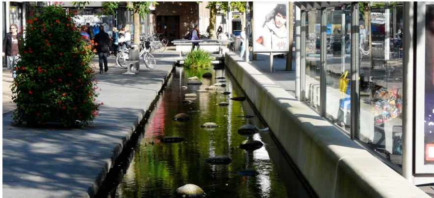
Figuur 9-3 Voorbeeld van stedelijke waterloop
