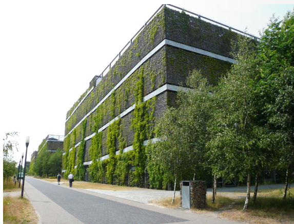
Referentie parkeergebouw, Hightech campus Eindhoven, ontwerp: CULD/Juurlink [+] Geluk
