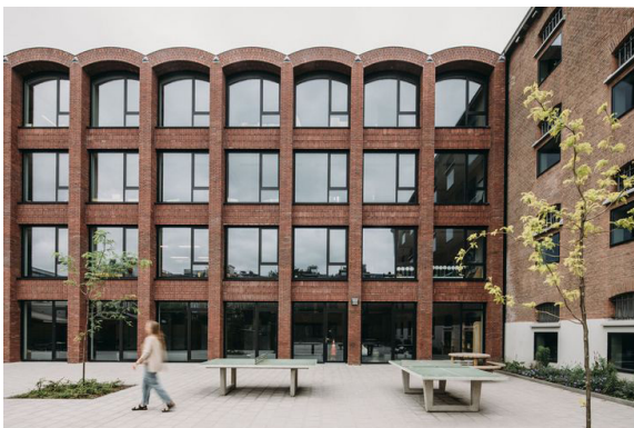
Referentie dakvorm, The British School of Amsterdam, Ontwerp: Atelier PRO / Van Hoogevest Architecten
