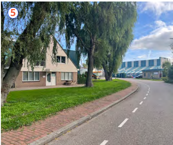
Huidige situatie Omringdijk
