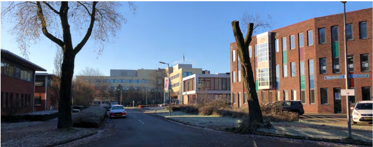
Werkgebouwen op het kantorenpark
