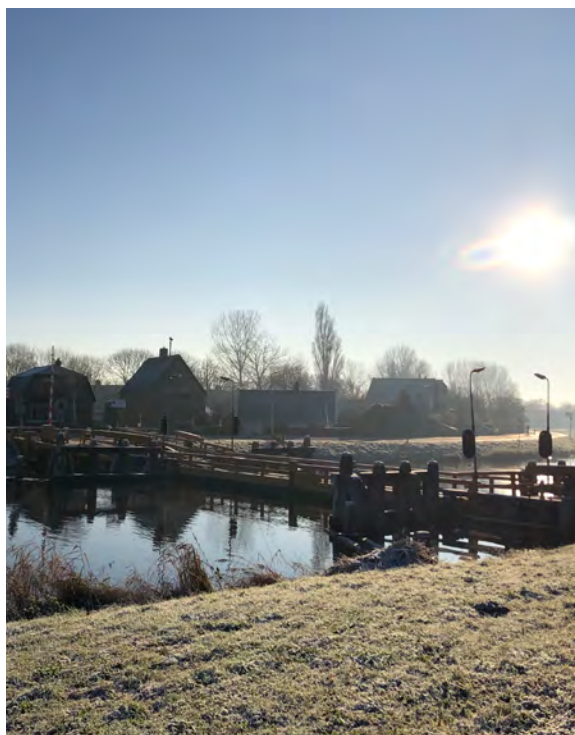
Monumenten aan de Westfriese Omringdijk
