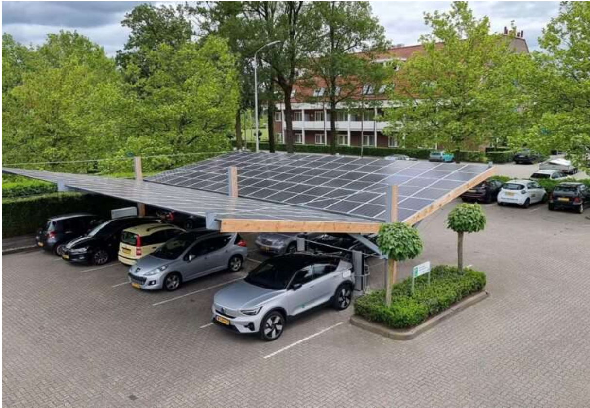
Combineren van parkeren en opwek zonne-energie
