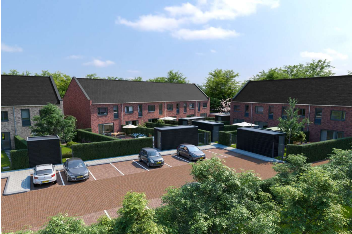
Parkeren op een binnenterrein aan de achterkant van de woningen
