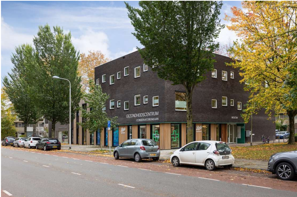
Gezondheidscentrum in het hart van de wijk (referentie gezondheidscentrum Conservatoriumlaan, BbDW)
