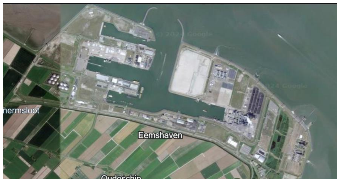
Afbeelding 2.7 Luchtfoto 2019 (bron: googleeearth.nl)
