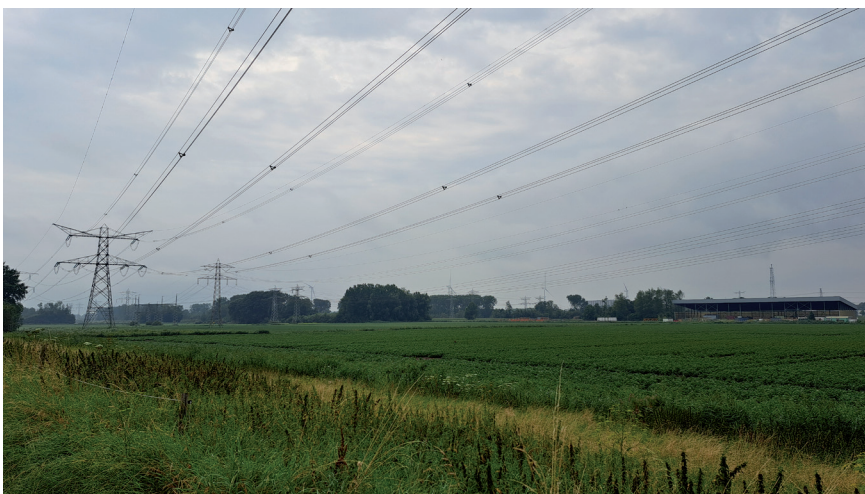
Afbeelding 41. Zichtbaarheid en verrommeling hoogspanningsmasten
