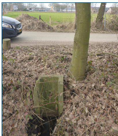
Relict waterinlaatconstructie vloeiveide aan de Molenstraat, 2019
