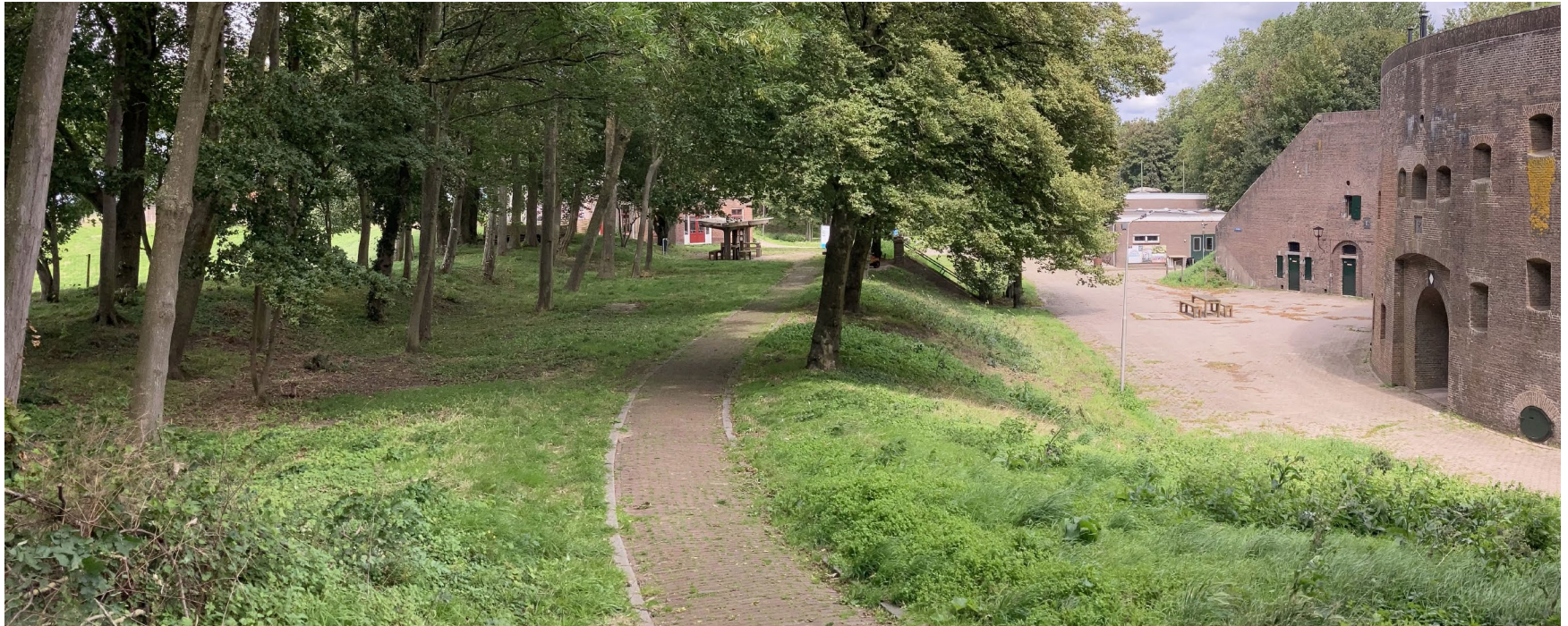
Foto van de huidige situatie: hier is zichtbaar dat de kruin van de waterkering lager ligt op deze locatie.
