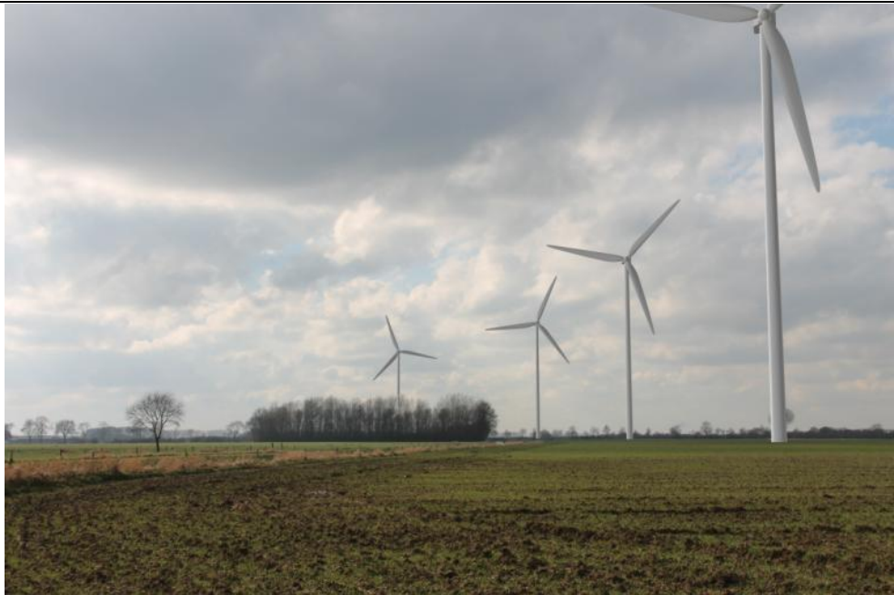
Figuur 11 Windpark op een afstand van 5 keer de tiphoogte; de windturbines zijn beeldbepalend en zeer dominant aanwezig.
