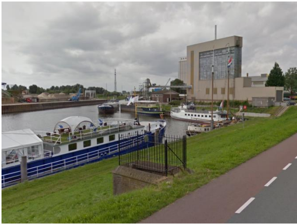
Afbeelding 17 Meetpunt in de Grebbedijk tegenover het Dijkstoelhuis in Wageningen, met op de achtergrond de Rijnhaven. Bron: Google Streetview.
