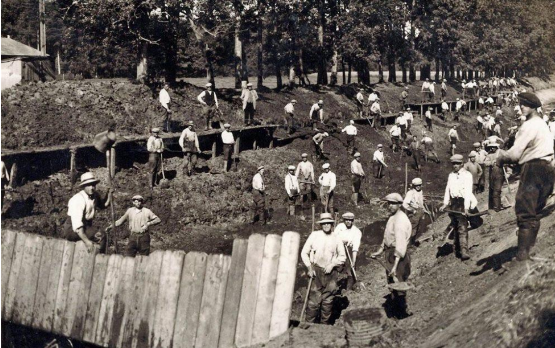
Afbeelding 8 Foto van de werkzaamheden in het kader van de aanleg van het Valleikanaal. Bron: http://www.utrechtsecanons.nl/utrecht/regio-eemland/leusden/valleikanaal .
