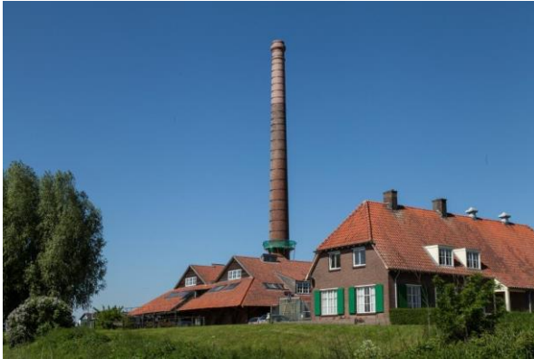
Afbeelding 12 Steenfabriek De Bovenste Polder. Bron: BOEi.
