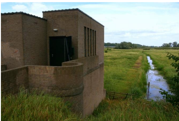
Afbeelding 14 Pompgemaal aan de Pabstsendam 1 in Wageningen. Bron: Open Monumentendag Wageningen.
