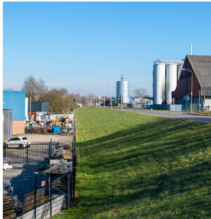
De dijk is herkenbaar door het groene binnentalud
