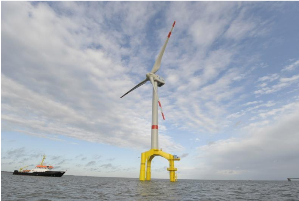
Figuur 3 Voorbeeld van een tripile fundatie 2 .
