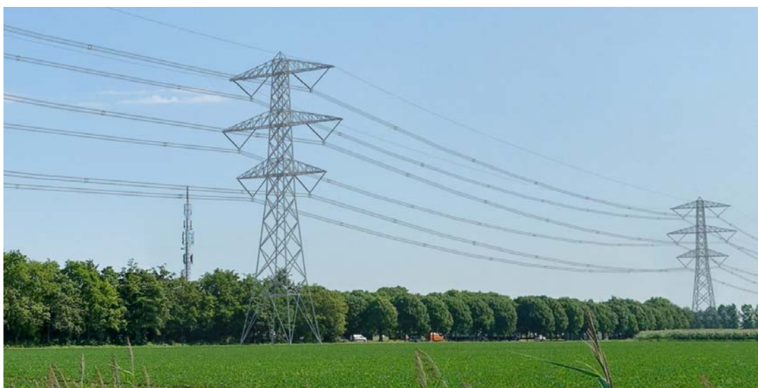
Figuur 1.14 Visualisatie van een Moldau mast in het landschap (bron: projectatlas Zuid-West 380kV-oost)
