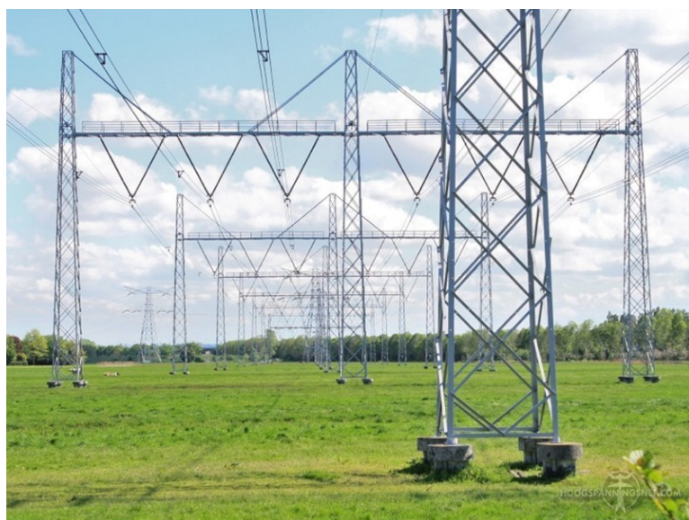
Figuur 8.8 Foto van portalen. Bron: hoogspanningsnet.com
