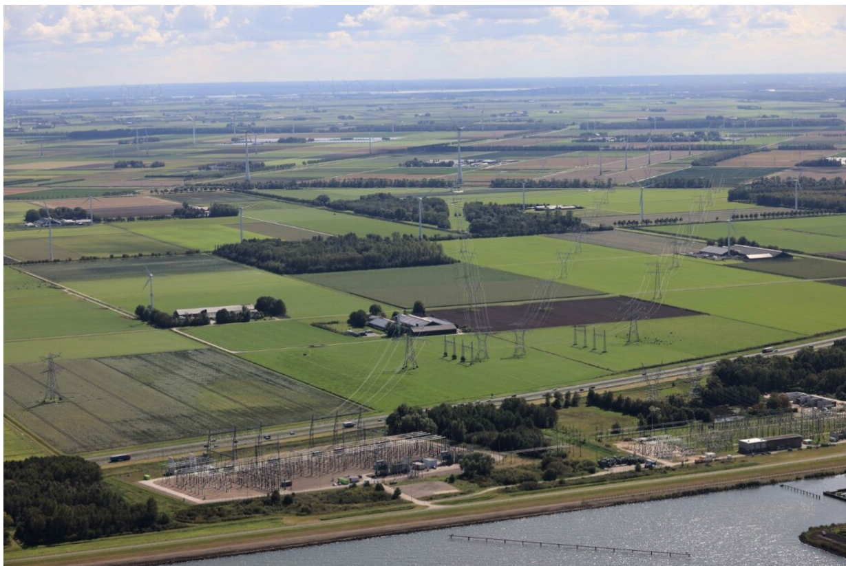
Figuur 2.3 Luchtfoto 380 kV-hoogspanningsstation Lelystad (links) en 150 kV-hoogspanningsstation Lelystad (rechts)
