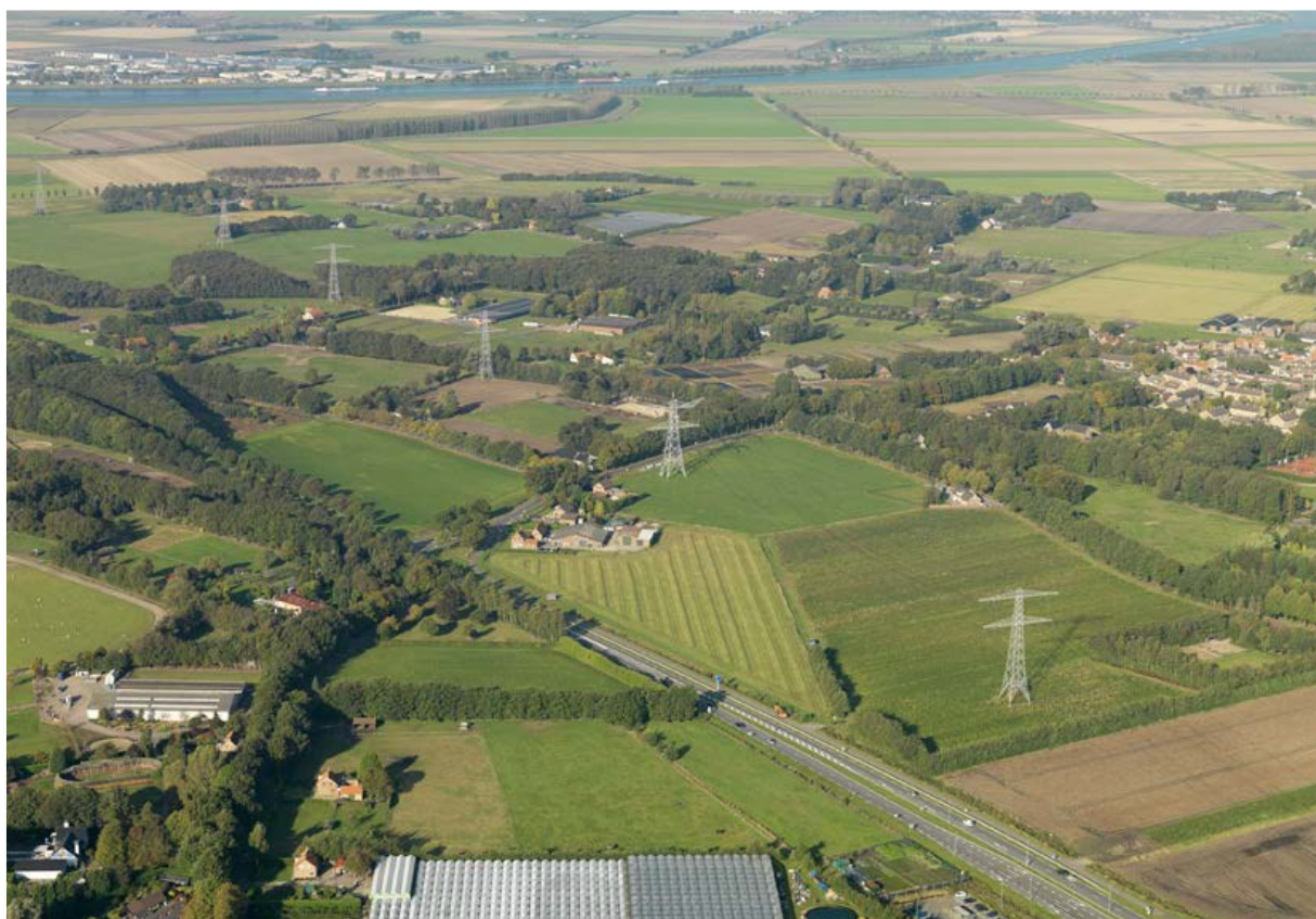
Figuur 3.1 Een 380 kV verbinding in een kleinschalig Brabants landschap: het landschap met historische, karakteristieke verkaveling en beplanting lopen 'ongestoord' onder de verbinding door. (bron: Landschap en hoogspanningsnet, 2017)
