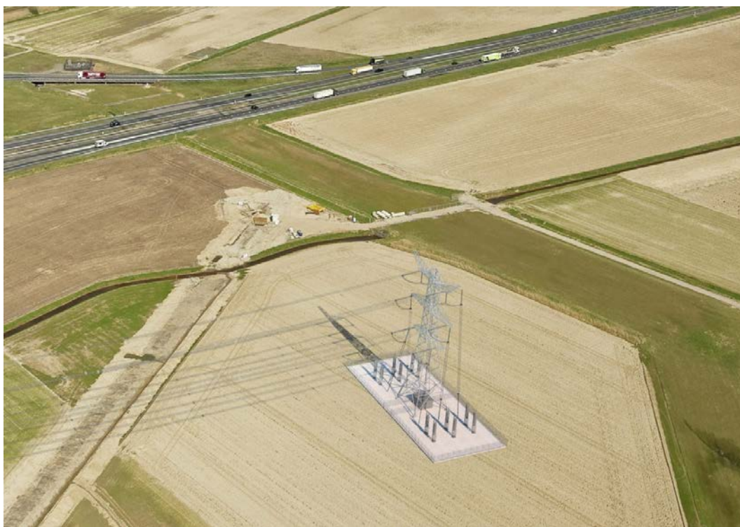
Figuur 8.8 voorbeeld van een opstijgpunt bij de 380 kV-verbinding Rilland-Tilburg
