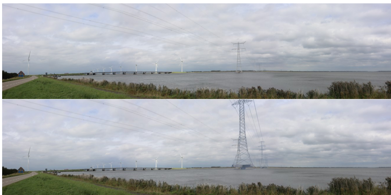
Figuur 6.28 Huidige situatie (boven) en fotomontage nieuwe situatie (boven) met deeltracé PA12a, bij de oversteek van het Ketelmeer
