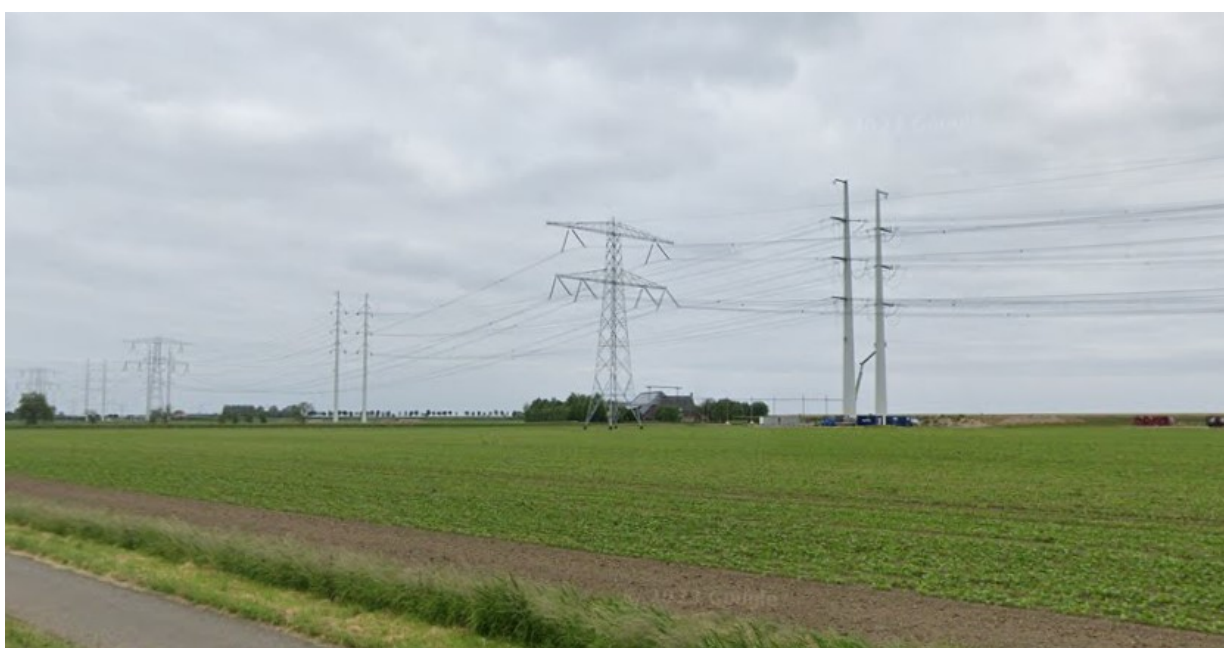
Figuur 2.2 Naast elkaar een 380 kV vakwerkmast ('Eiffeltoren') en een 380 kV wintrackmast (pilaren) (bron: Google Streetview, t.p.v. A58/N289 nabij Rilland)
