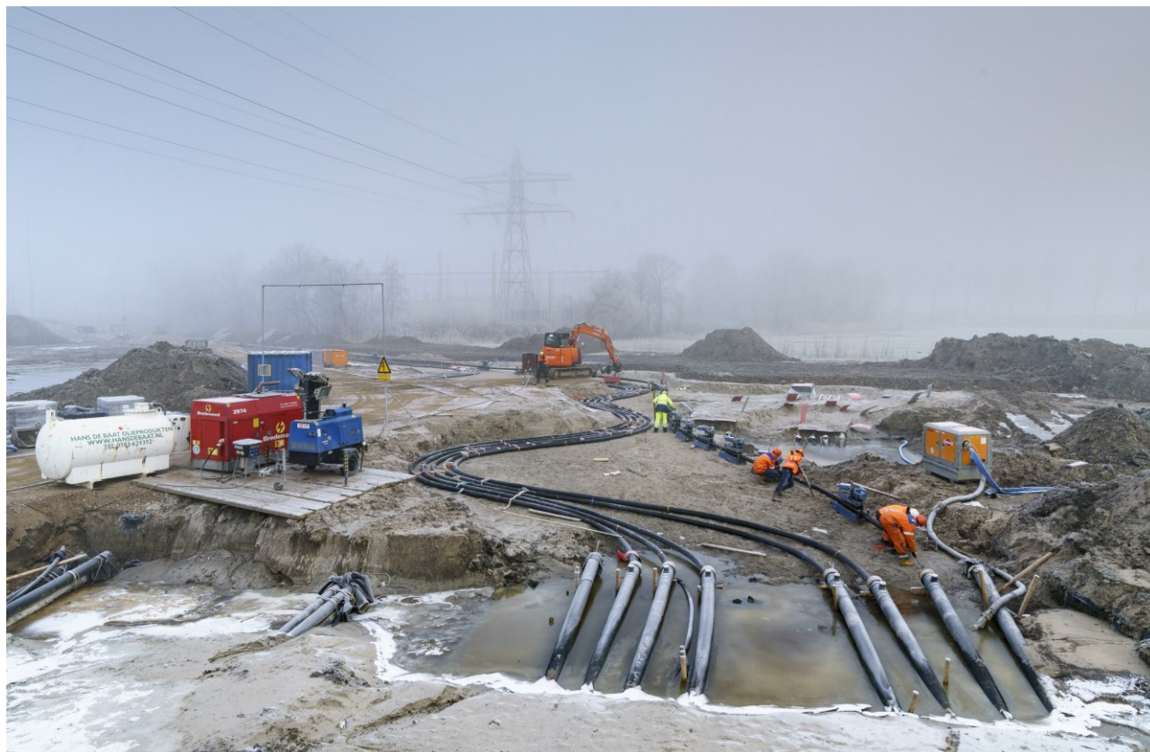
Figuur 2.7 Gestuurde boring 380 kV kabels
