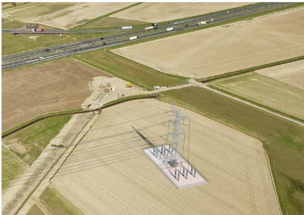
Figuur 2.8 Opstijgpunt 380 kV-verbinding (foto van de verbinding Rilland-Tilburg)
