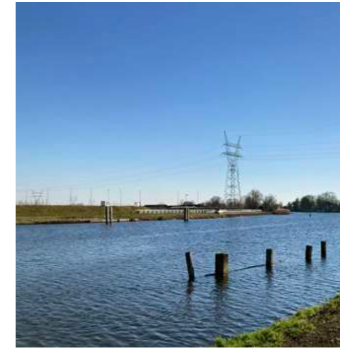
De Vecht voor de toevoer van water naar de inundatiegebieden met de dijk aan de overzijde als element van het watermanagementsysteem
