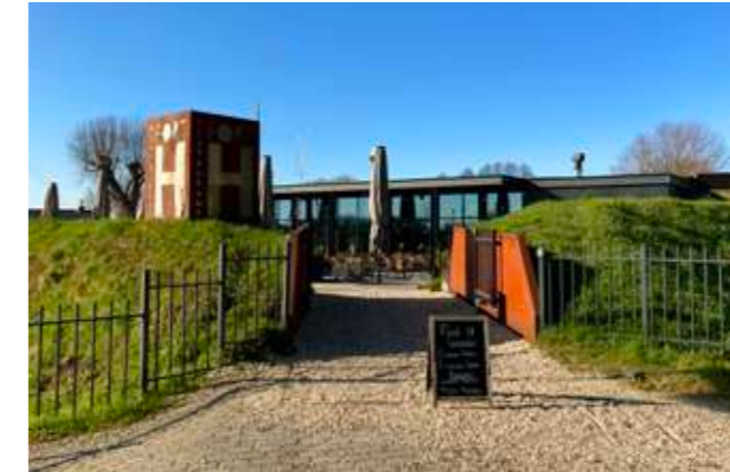
Fort H ten zuiden van vestingstad Muiden (materialisatie SvA = beton)
