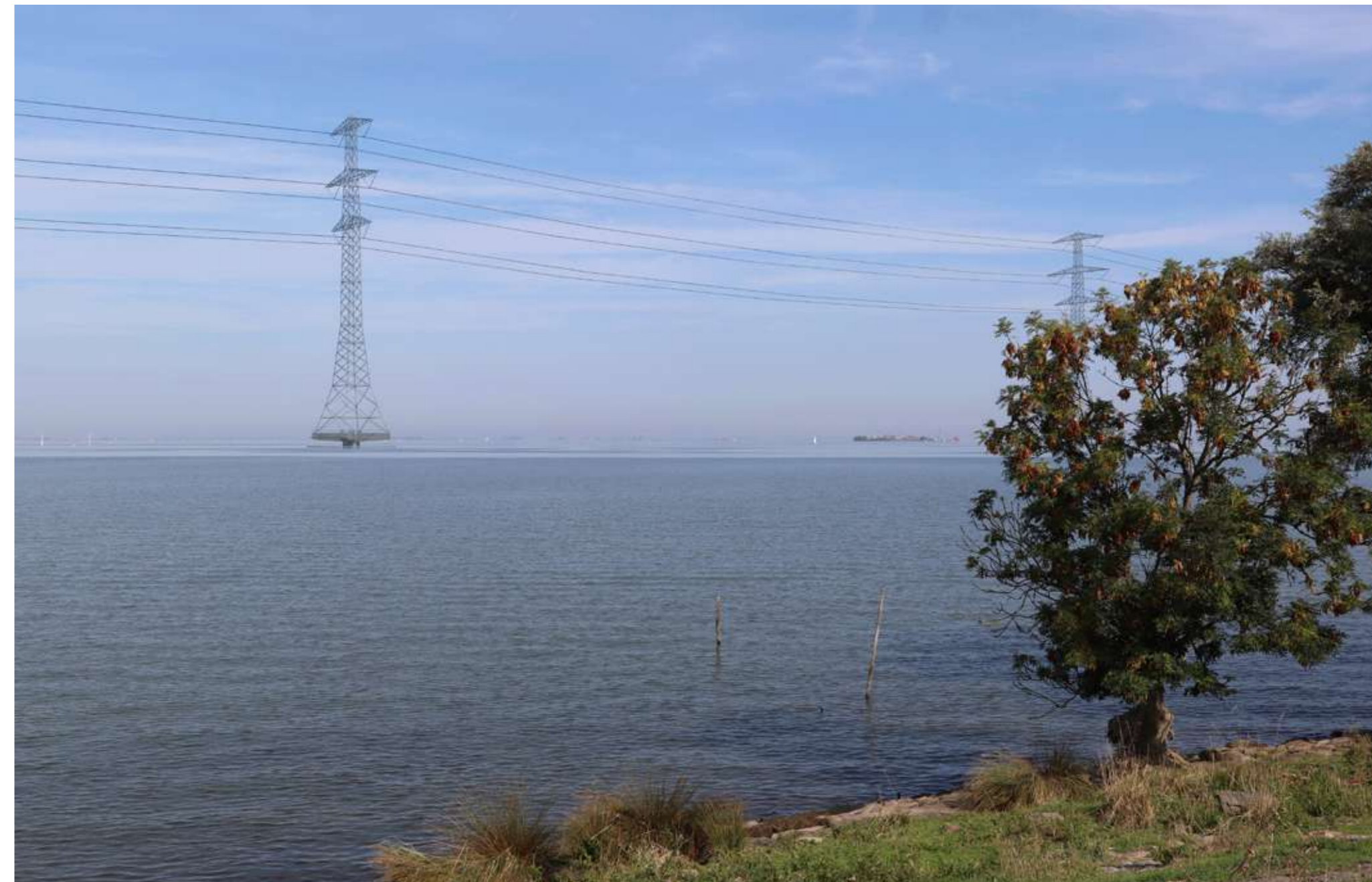
Inzoom op de fotomontage van de vorige pagina. Het plaatsen van een nieuw hoogspanningstracé draagt bij aan industrialisatie van het gave linie ensemble. Vanaf Muiden gezien overstijgt de hoogspanningslijn de schaal van het linie ensemble nog meer dan in de vorige fotomontage waardoor de zichtbaarheid van Forteiland Pampus 'verkleint'.
