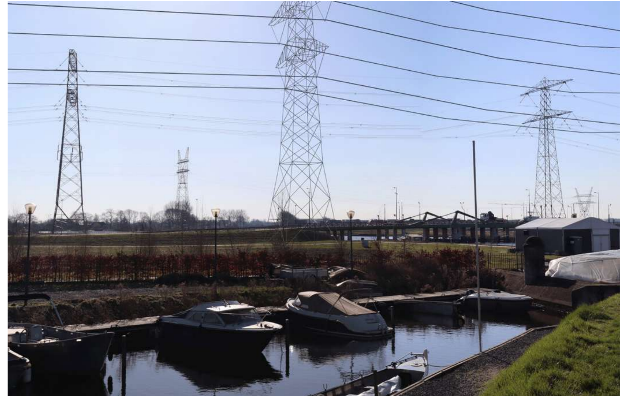
Inzoom op de fotomontage van de vorige pagina. Met het plaatsen van een nieuw hoogspanningstracé verschuift het zicht vanaf het fort, dat reeds verstoord is, nog meer naar de hoogspanningslijn in plaats van het omliggende landschap. De visuele openheid van de verboden kringen en de relatie van het militair werk met de omgeving is nauwelijks te herleiden.
