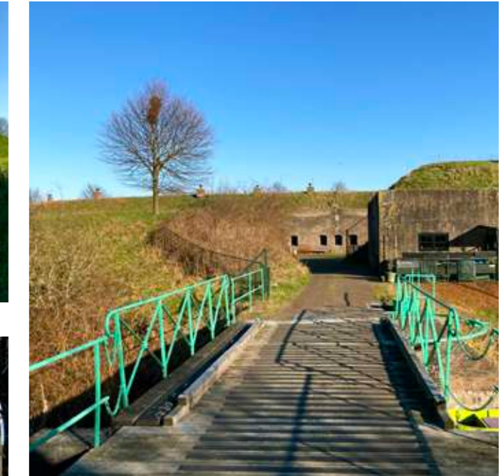
Fort Ronduit ten noorden van vestingstad Naarden (materialisatie NHW = baksteen)
