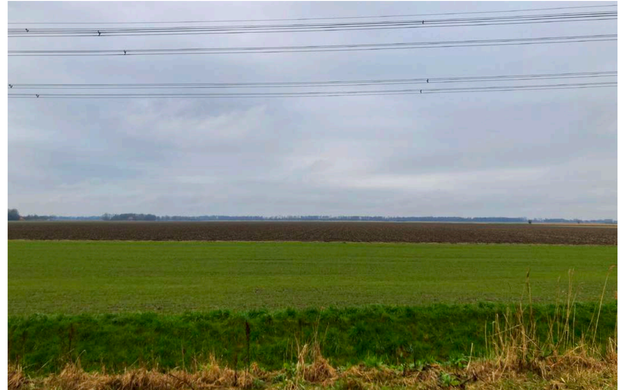
Horizontale lijnen tussen hoogspanningsmasten vallen slechts beperkt op. De hoogspanningslijnen zweven als autonoom element boven het landschap.
