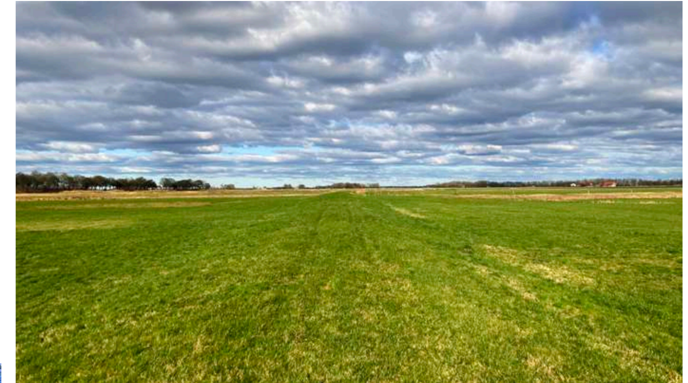
Dijktracé aan de oostzijde van het eiland. Dit is niet de originele dijk, die ligt in de ondergrond.
