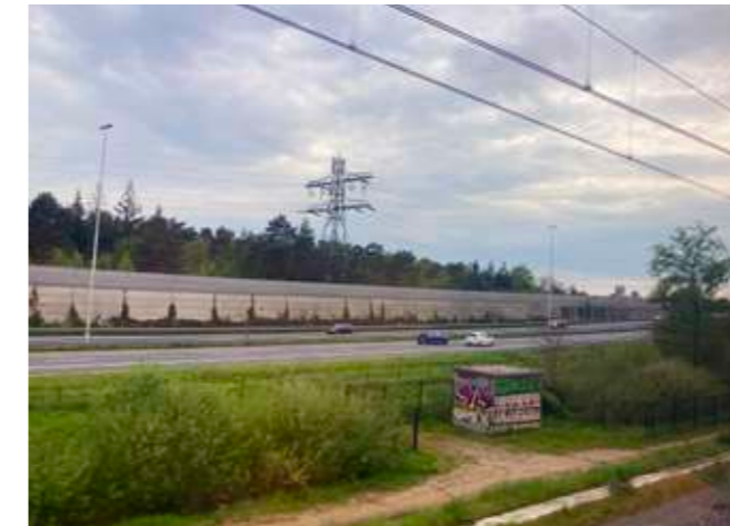
De mastvoet van een hoogspanningslijn, die is gekoppeld aan een snelweg en spoorlijn, gaat deels op in het landschap vanwege bosschages
