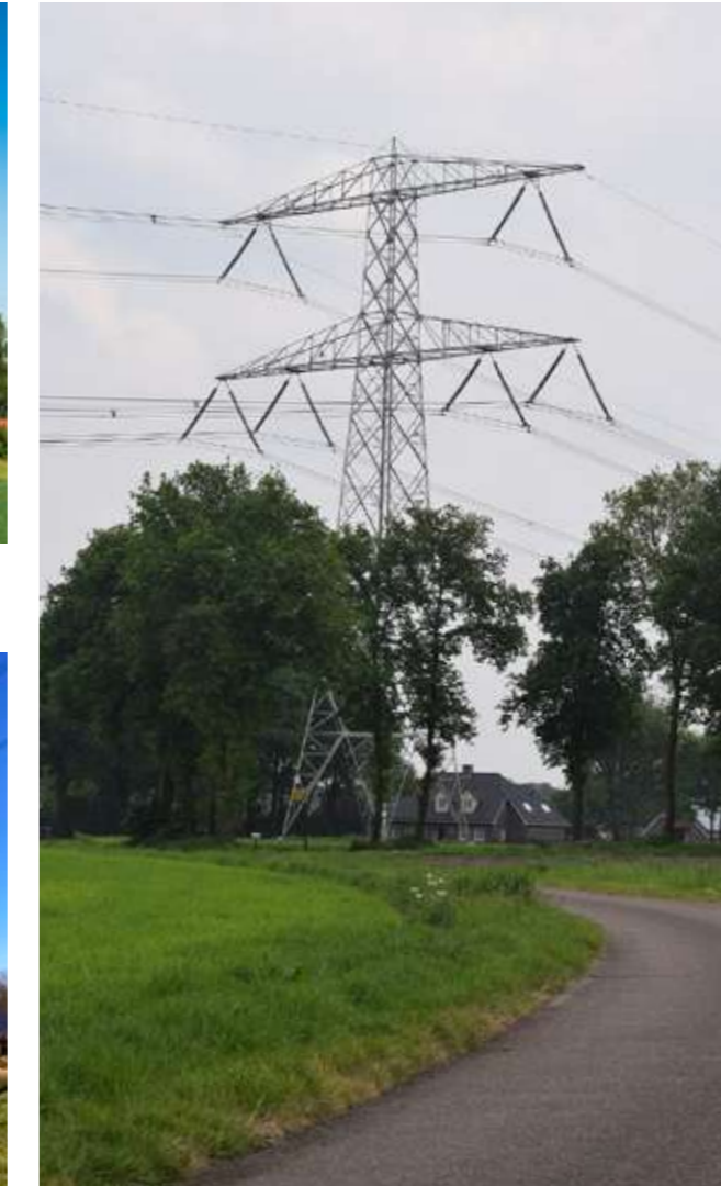
De mastvoet van deze hoogspanningsmast wordt deels gecamoufleerd door bomen Bron: https://nl.m.wikipedia.org/wiki/Bestand:Hoogspanningsmast_Merselo.jpg
