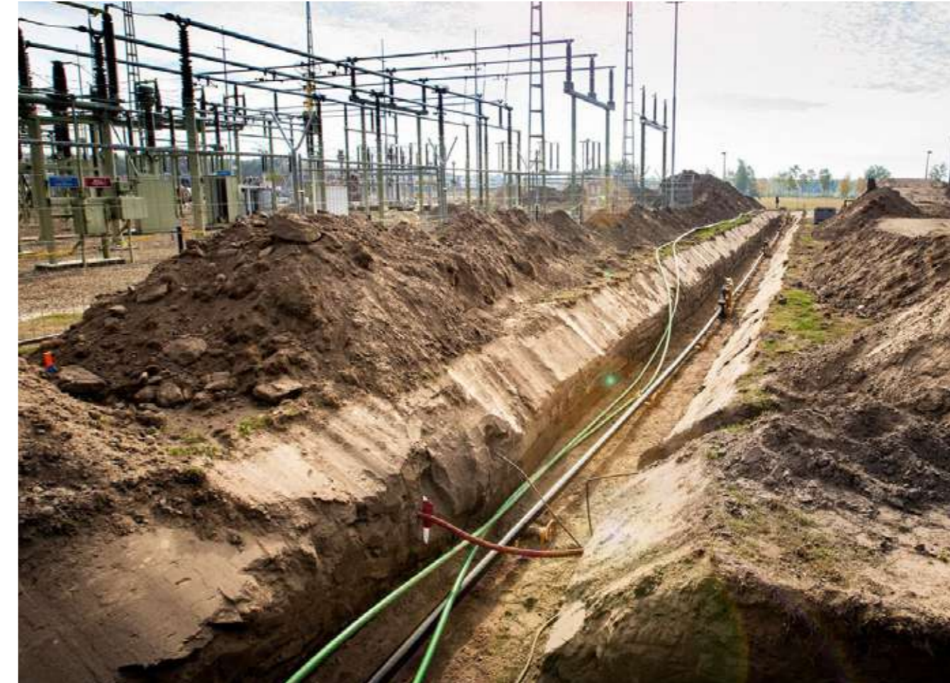
Referentiebeeld van het ondergronds aanleggen van een hoogspanningslijn: E-Power-Pipe Bron: https://www.tennet.eu/nl/over-tennet/innovatie-en-partnerships/horizontaal-boren
