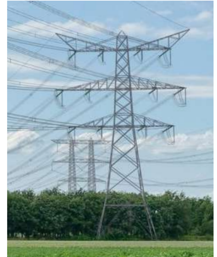
Foto van een vakwerkmast (type Moldau) Bron: https://www.hoogspanningsnet.com/moldau-hoekmast-uit-tennet-visualisatie/
