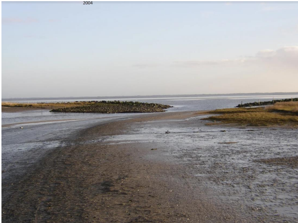
Figuur 16. Monding van de Oerdsloot. Duidelijk zichtbaar de oeververdediging met stortstenen aan linker- en rechterzijde van de monding (foto 2004).
