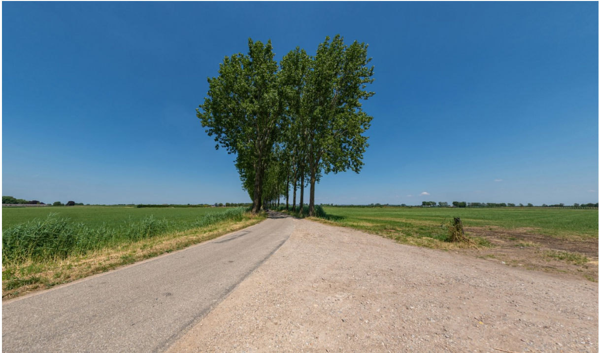
Afbeelding VIII.12 Zichtpunt Panderweg Oost (in noordelijke kijkrichting) in de huidige situatie
