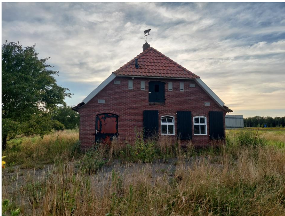
Figuur 6.3 Voorbeeld faunahuis met witte dakoverstekken, toegankelijke zolder en ingemetselde kasten. Bron foto: Ecogroen
