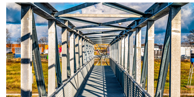
Tijdelijke brug Belcrumhaven (TPJ verhoeven photography)
