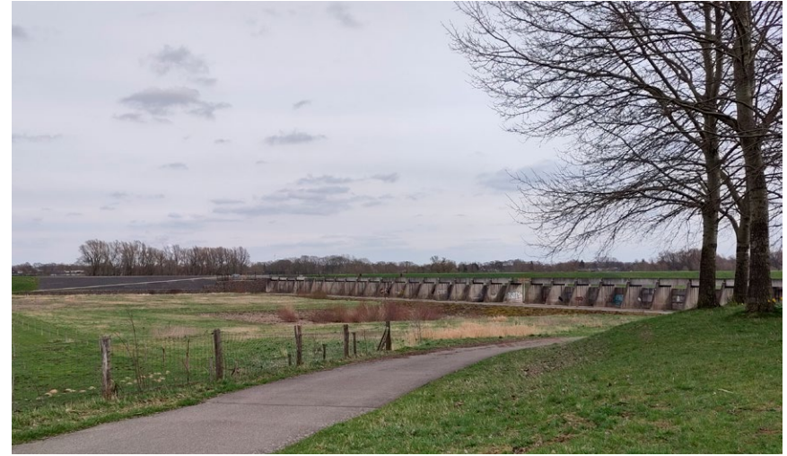
Regelwerk Hondsbroeksepleij, weinig architectonische expressie.
