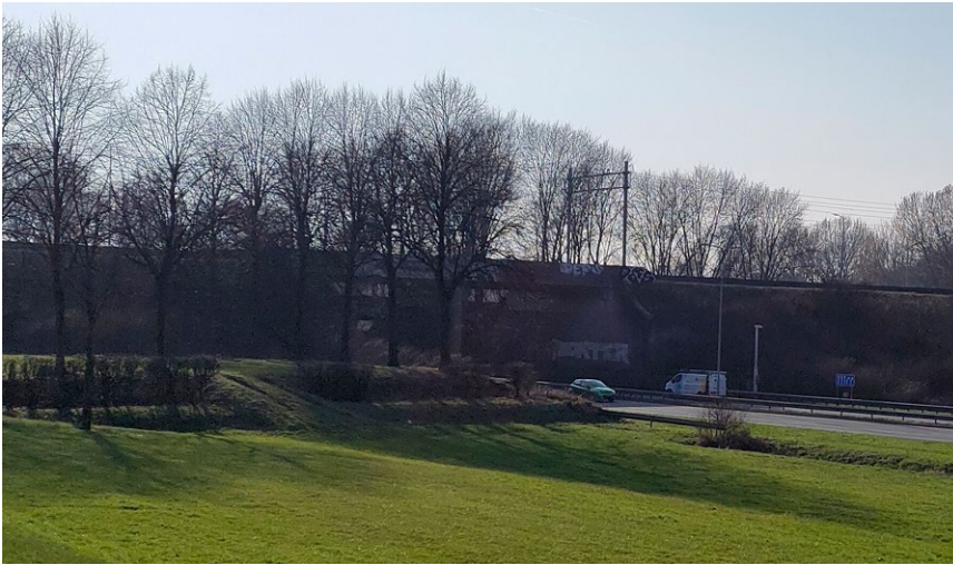
Restanten van fort Westervoort, ingeklemd tussen infrastructuur
