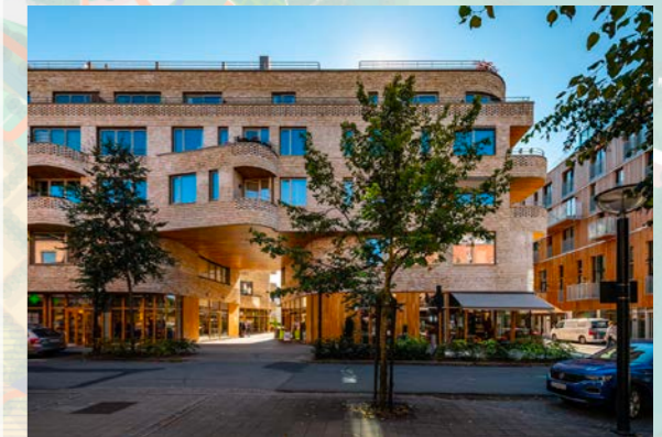
Afwisselende bebouwing rondom het voorzieningshart
