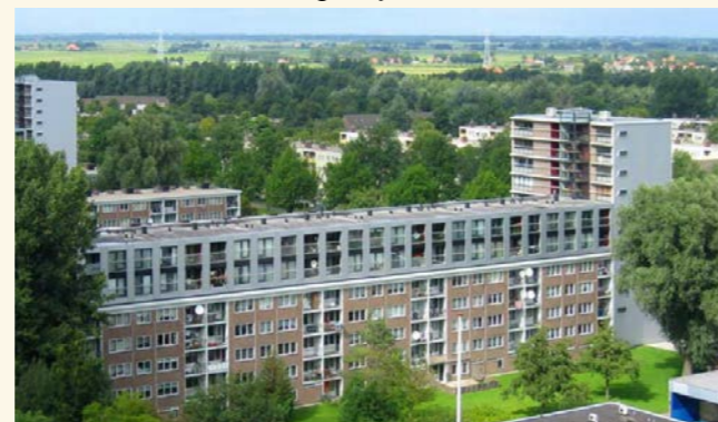
Optoppen van bestaande flats
