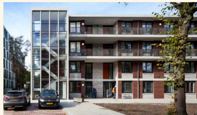
Nieuwe ontsluiting van de galerijen, met trap en lift
