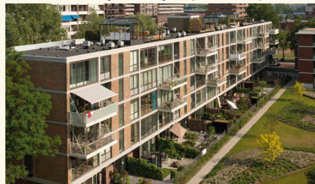
Aan- en verbouwen van bestaande flats
