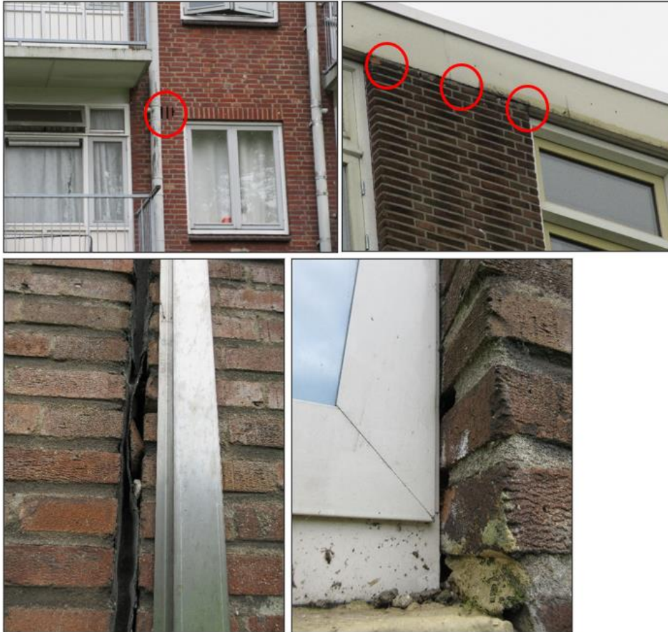
Figuur 2.4. Voorbeelden van voor vleermuizen geschikte openingen binnen het plangebied. Bron: Antea Group, 2023.
