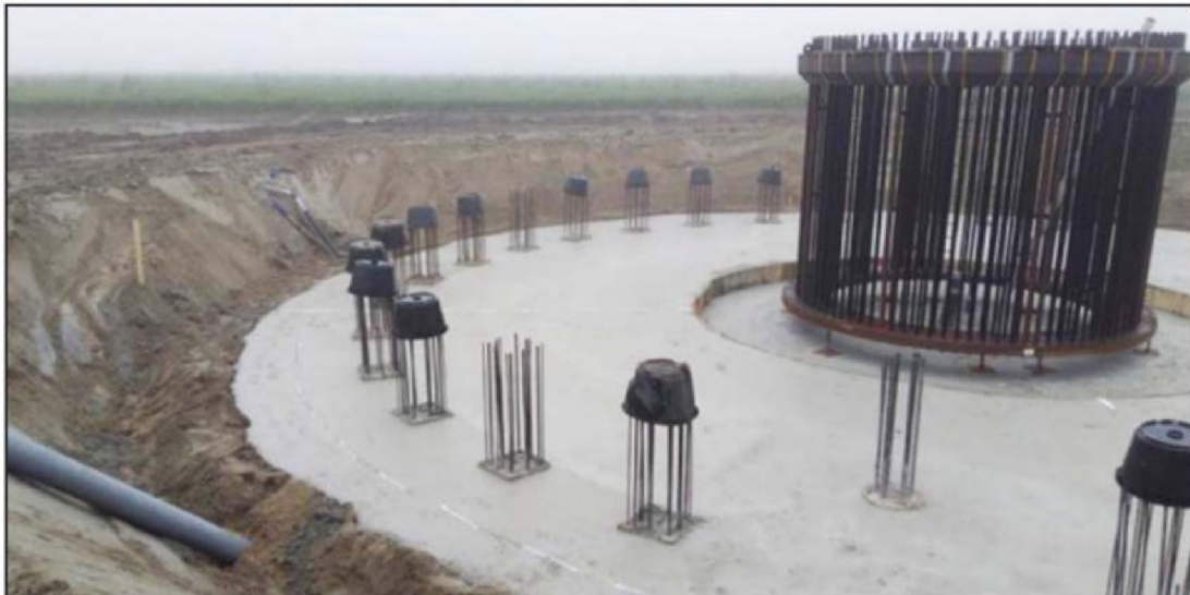
Figuur 3.2 Ankerkooi en wapeningsstaal heipalen (voorbeeld)
