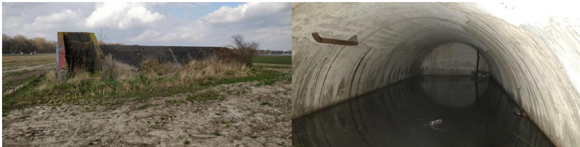
Afbeelding 5.3 Impressie van de bunker aanwezig in het noorden van het plangebied; niet geschikt als verblijflocatie voor vleermuizen
