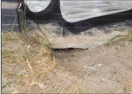
Afbeelding 9: Ruimte onder fundering bebouwing
