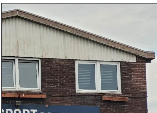
Afbeelding 5: Golfplaat gevelbekleding
