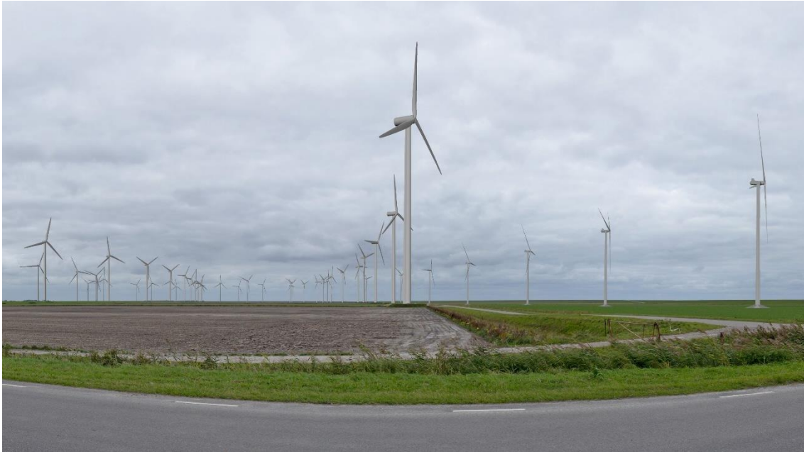
Figuur 15.12 Illustratie verhoogd fundament vanaf standpunt 6
