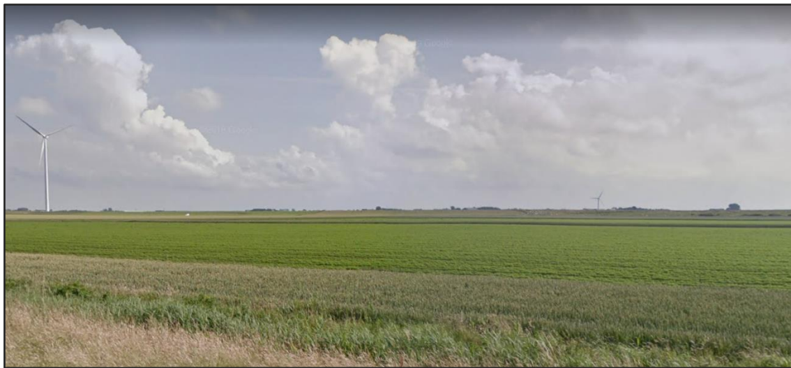
Figuur 9.1 Slaperdijk in de Eemshaven
