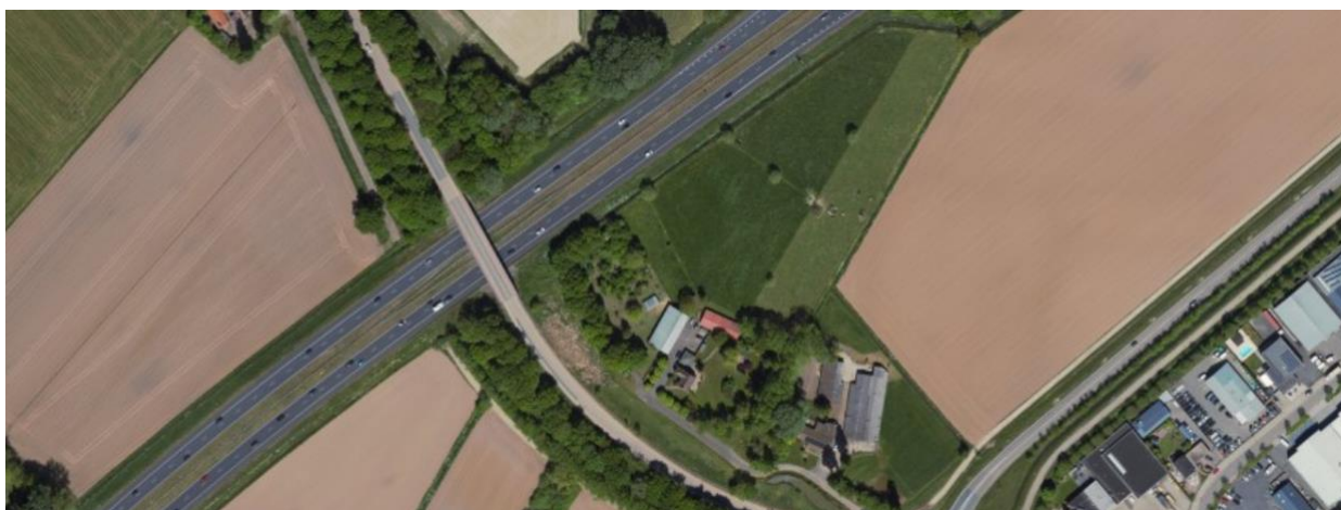
Figuur 4-6 Woningbouw bij 137,2
