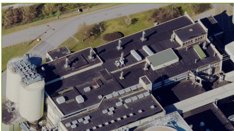
Figuur 3.7: FOI 4 gebouw
