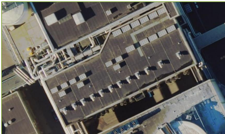
Figuur 3.8: 'FOI 5' gebouw
