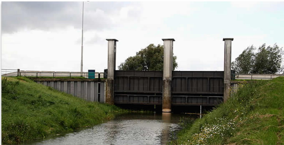
Afbeelding 42 De uitwateringssluis aan de landzijde op een recente foto. Bron: www.sluizenenstuwen.nl
