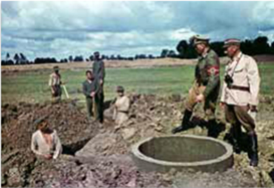
Afbeelding 2 Aanleg van een Kochbunker met aansluitende loopgraaf. Bron: D. Kastelein & M. Groothedde, De Bunker van Morgan. Een archeologisch onderzoek naar een bunker bij Huis 't Velde te Warnsveld (Zutphen 2017).
