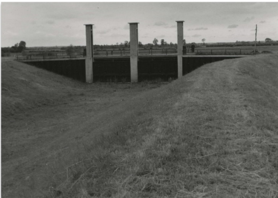
Afbeelding 40 Uitwateringssluis in de monding van het Stroomkanaal van Hackfort, gezien vanaf de landzijde. Foto uit de periode 1955-1960. Bron: beeldbank Rijkswaterstaat, ID349317
