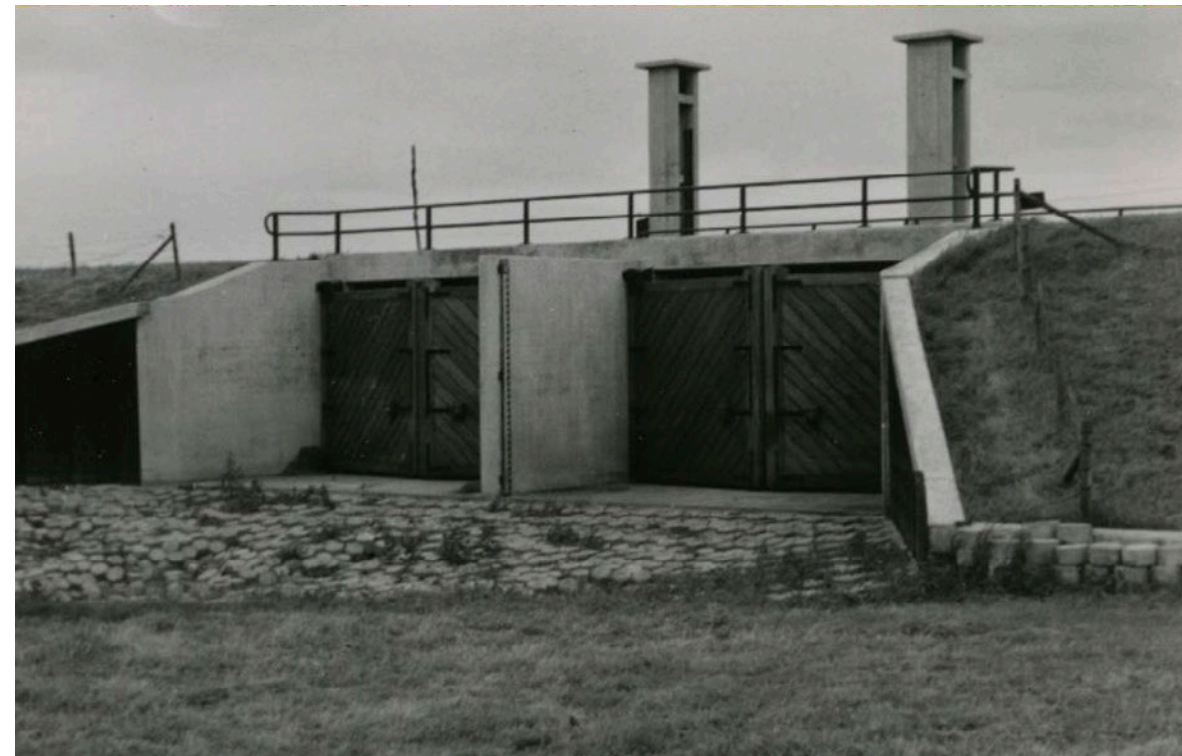
Afslaatwerk stroomkanaal van Hackfort, gezien vanaf de IJsselzijde. Foto uit de periode 1955-1960
