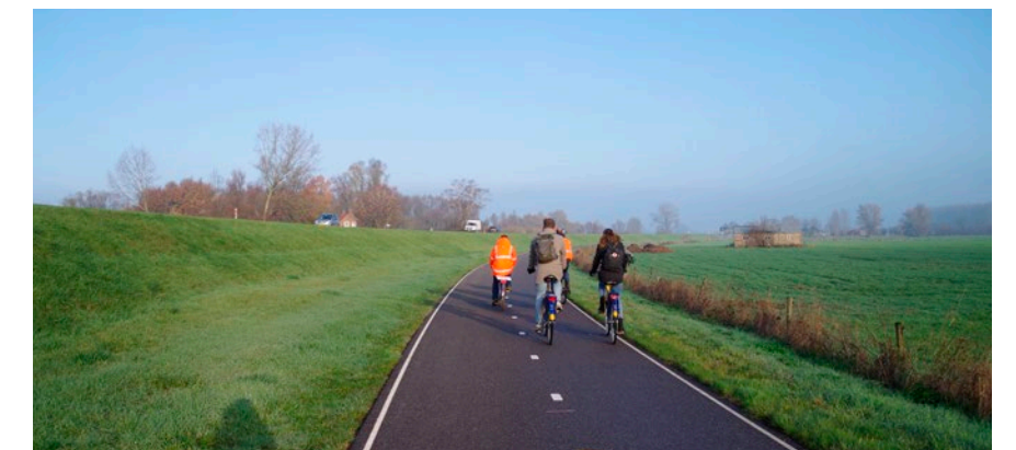
Ter hoogte van de N314 ligt het fietspad aan de teen van de dijk, er is geen beleving van het buitendijkse gebied en de IJssel
