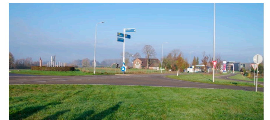
Kruispunt N314, aantakking Liudgersdijk: onoverzichtelijke oversteek waarbij verkeersveiligheid in het gedrang komt
