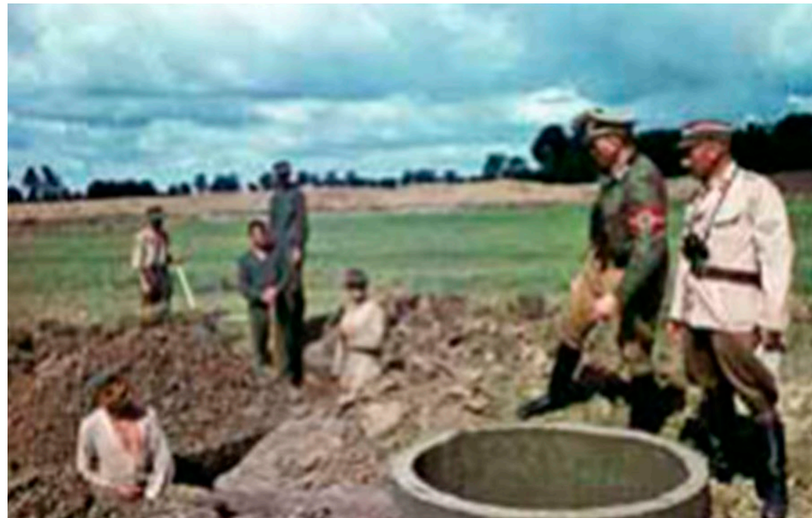
Aanleg van een Kochbunker met loopgraaf
