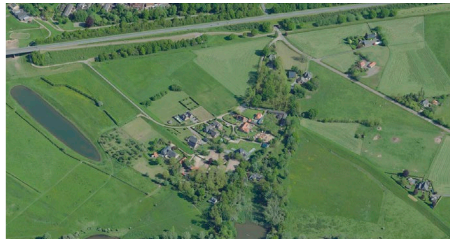
De rivierduin Stokebrand is een van de natuurlijke hogere gronden binnen dijktraject Den Elterweg De aantakking van de dijk aan weerszijden van de rivierduin is goed zichtbaar, waarna de dijk verdwijnt in het agrarische cluster
