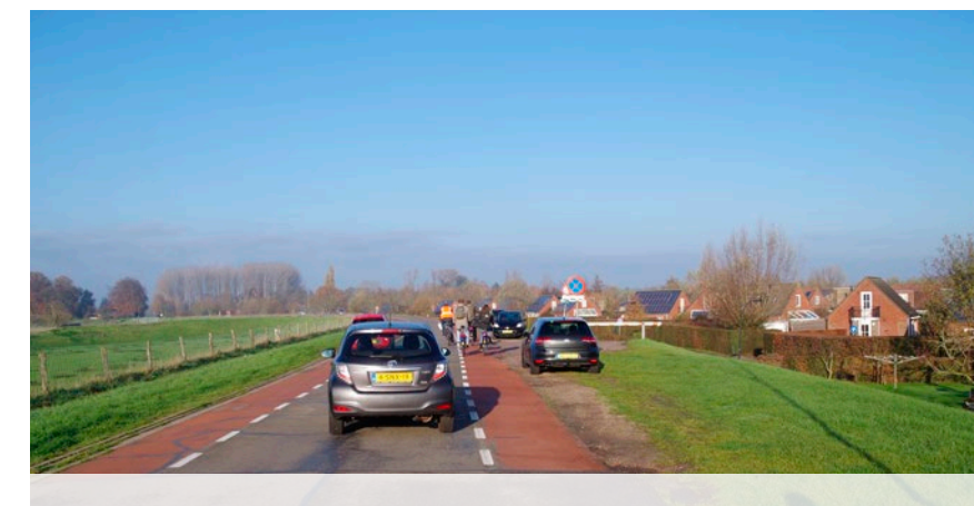
Wordt veel geparkeerd op dijk, in gras of op grasbetontegels Gemengd verkeer, fietssuggestiestroken, recreatief medegebruik Herprofilen weg?
