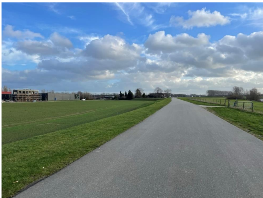
Figuur 5-1 Dijktaaluds en bermen met gras, binnendijks landbouw en buitendijks grasland (uiterwaarden). Foto: Royal HaskoningDHV, januari 2023.
