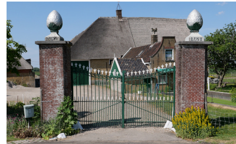
Hoeve Bouwlust-Zeldenrust in de huidige staat.
