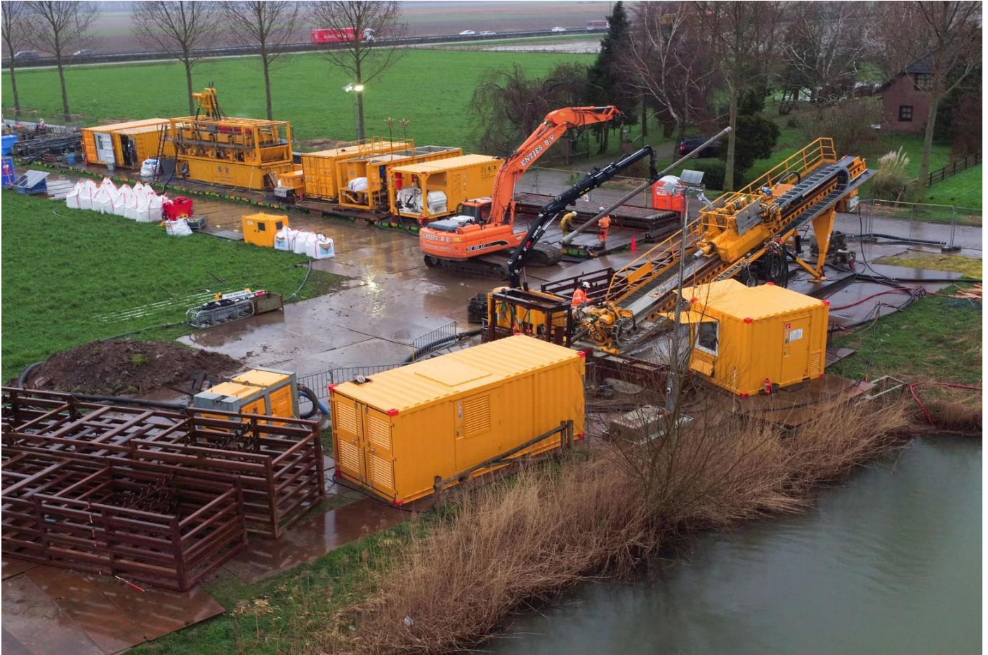
Figuur 3-6 Boorstelling (rig) voor de uitvoering van een horizontaal gestuurde boring.
