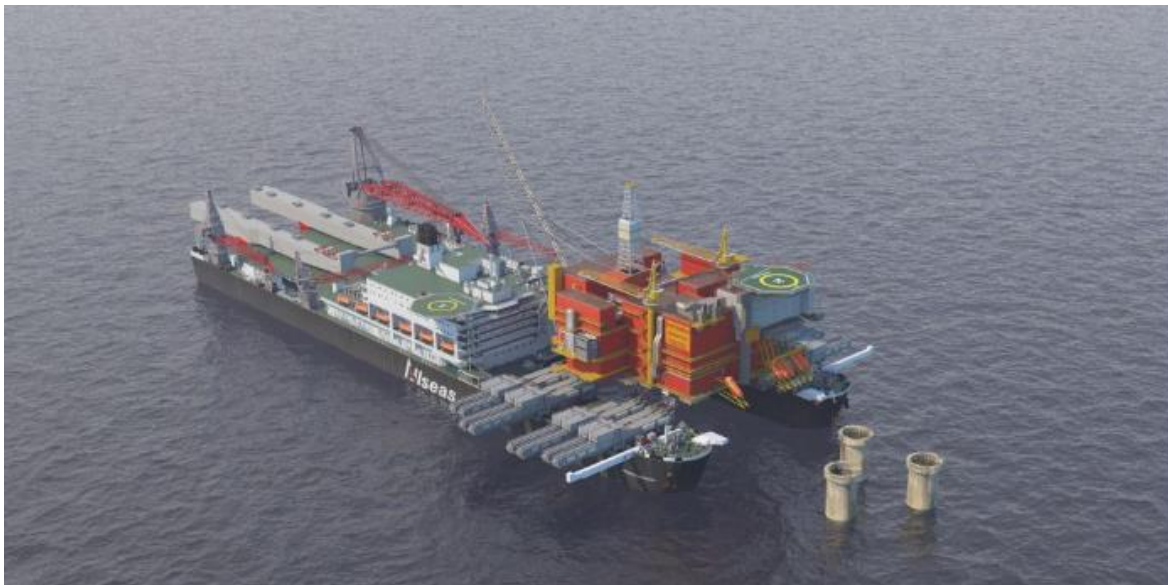
Figuur 1-4 Bovenbouw van onderen optillen met behulp van een catamaranschip (hier: "Pioneering Spirit")
