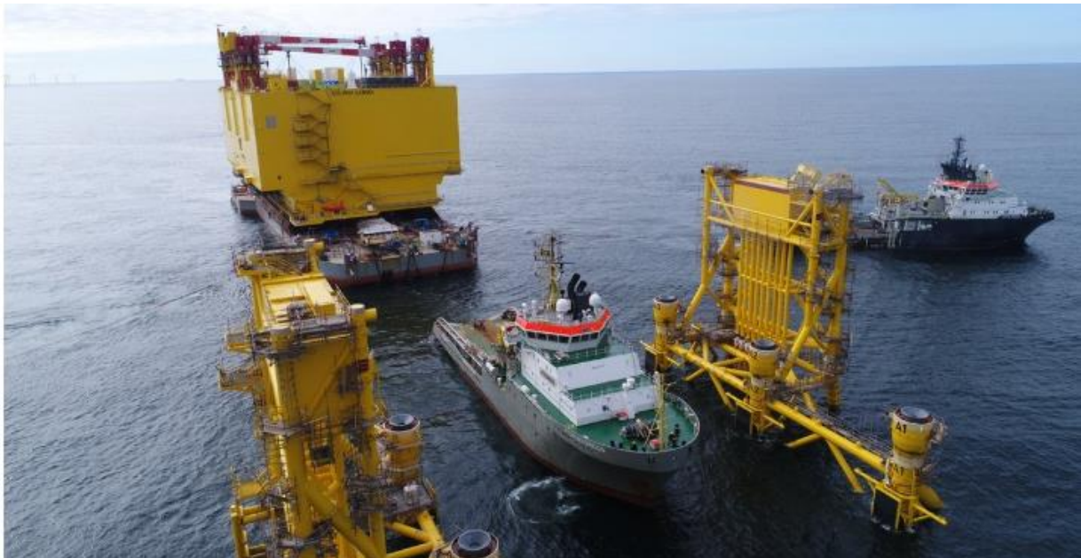
Figuur 1-6 Bovenbouw invaren en neerlaten door het transportschip te laten inzinken
