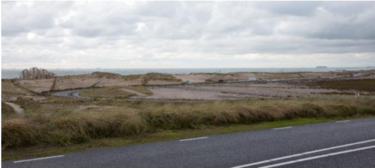
Figuur 6-4 Tweede Maasvlakte met kunstwerk de ‘Zandwacht’ in de duinen langs de Maasvlakteboulevard
