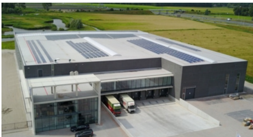
Zonnepanelen op daken
