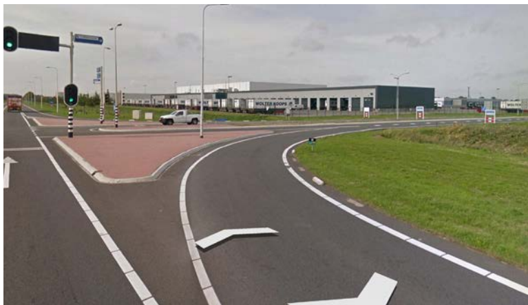
Bestaande entree Trekkersveld III
