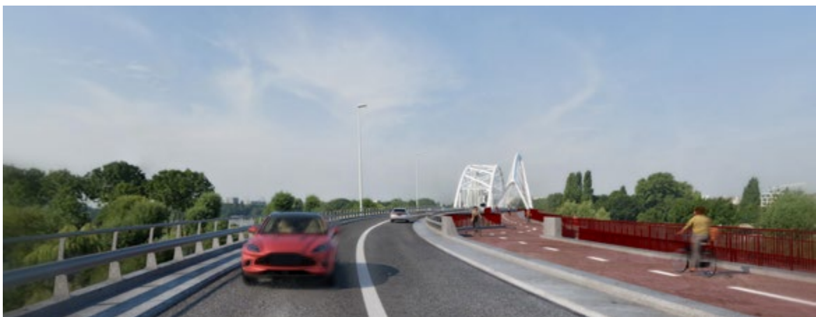
Figuur 4. Nieuwe indeling van de Amsterdamsebrug. Een tweerichtingsfietspad sluit aan op de nieuwe fietsbrug. Een voetpad resteert alleen op de hoofdo overspanning, tussen de trappen.
