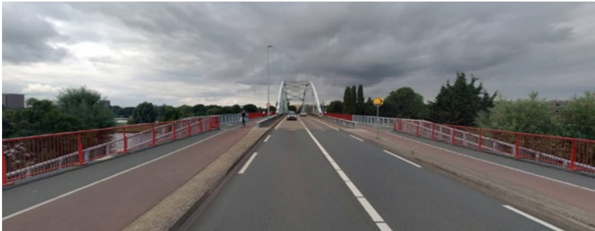
Figuur 3. De huidige indeling van de Amsterdamsebrug. Aan weerszijden van de weg ligt een éénrichtingsfietspad en een - ook door fietsers gebruikt - voetpad.
