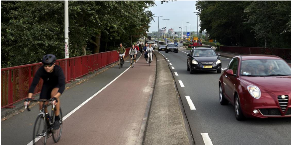
Figuur 8-2 Beeld van het fietsverkeer op de Amsterdamsebrug. De fietsstrook is te smal voor het gebruik door groepen fietsers en fietsers met verschillende snelheden. Fietsers maken veelvuldig gebruik het voetpad (zwart), leidend tijd gevaarlijke situaties.
