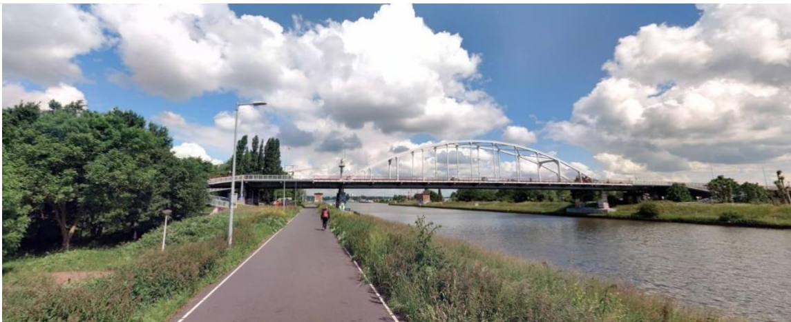
Figuur 12-5 Aanzicht van de Amsterdamsebrug en directe omgeving. Zicht vanuit het zuiden. (bron: Cyclomedia, 2022)
