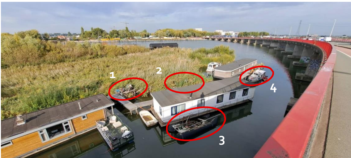
Figuur 12-10 Huidige situatie bij woonboten langs de Amsterdamsebrug. Te zien zijn een tweetal wrakken (1, 2) en tevens twee boten in zinkende staat (3, 4). Bron: eigen afbeelding, 2022
