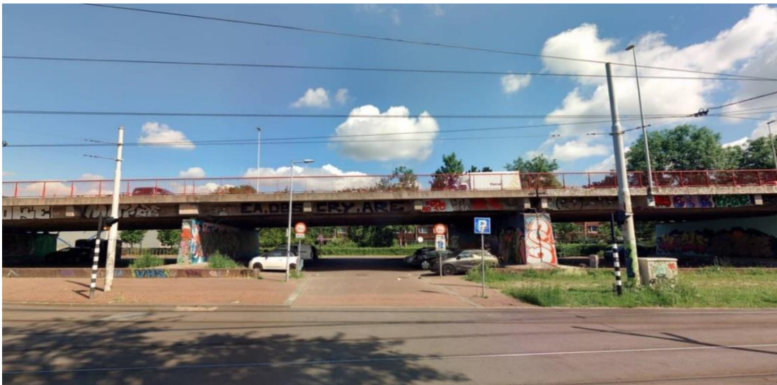
Figuur 11-13 Onderdoorgang t.h.v. tramhalte Flevopark (Bron: cyclomedia, 2022). Weinig zicht bestaat op de weinig belichte onderdoorgangen
