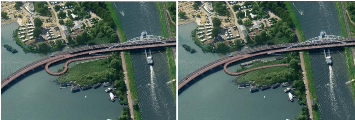
Figuur 5-14 Verschillende uitwerkingsvarianten voor de fietsverbinding naar de Zuider IJdijk (niet uitputtend)
