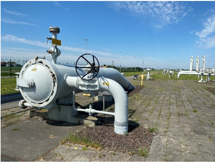
Figuur 3-2 Voorbeeld van pigfaciliteit (links). Bovengronds kan de pig worden ingebracht en wordt via de pigfaciliteit naar de ondergrondse leiding geleid. Rechts wordt het inbrengen van een pig weergegeven.
