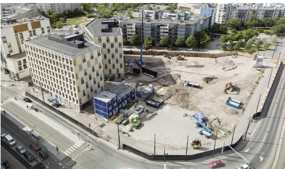
Figuur 6: Bouwplaats Wood City Helsinki.
