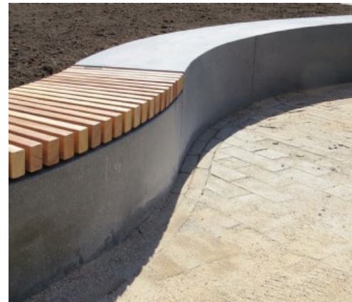
Betonnen zitranden met eventueel houten delen
