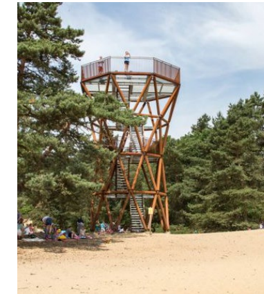
Houten uitkijktoren van zo'n 8 tot 10 meter hoog
