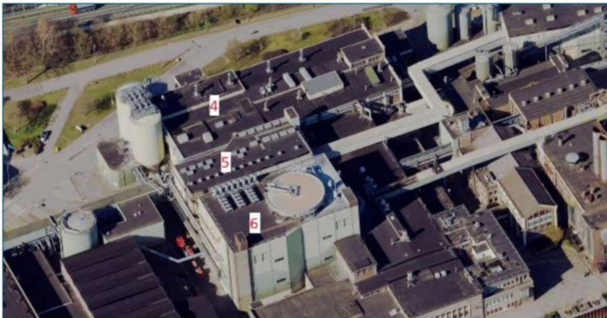
Figuur 3.6: Flotatie Ontinktings Installaties (FOI), met potentiële relevante geurbronnen
