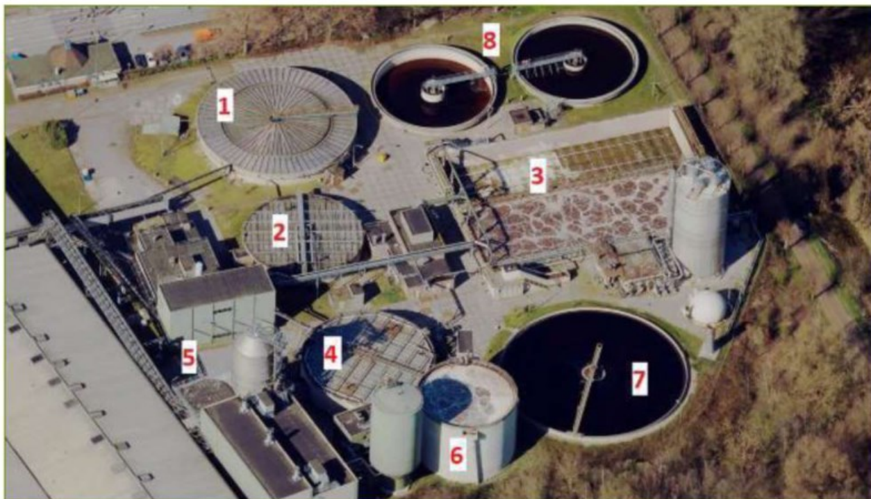
Figuur 3.4: Afvalwaterzuivering (AWZ), met potentiële relevante geurbronnen
