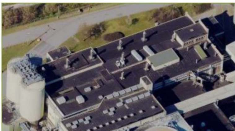
Figuur 3.7: FOI 4 gebouw
