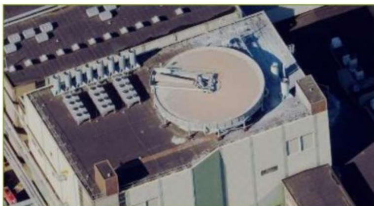
Figuur 3.9: FOI 6 gebouw
