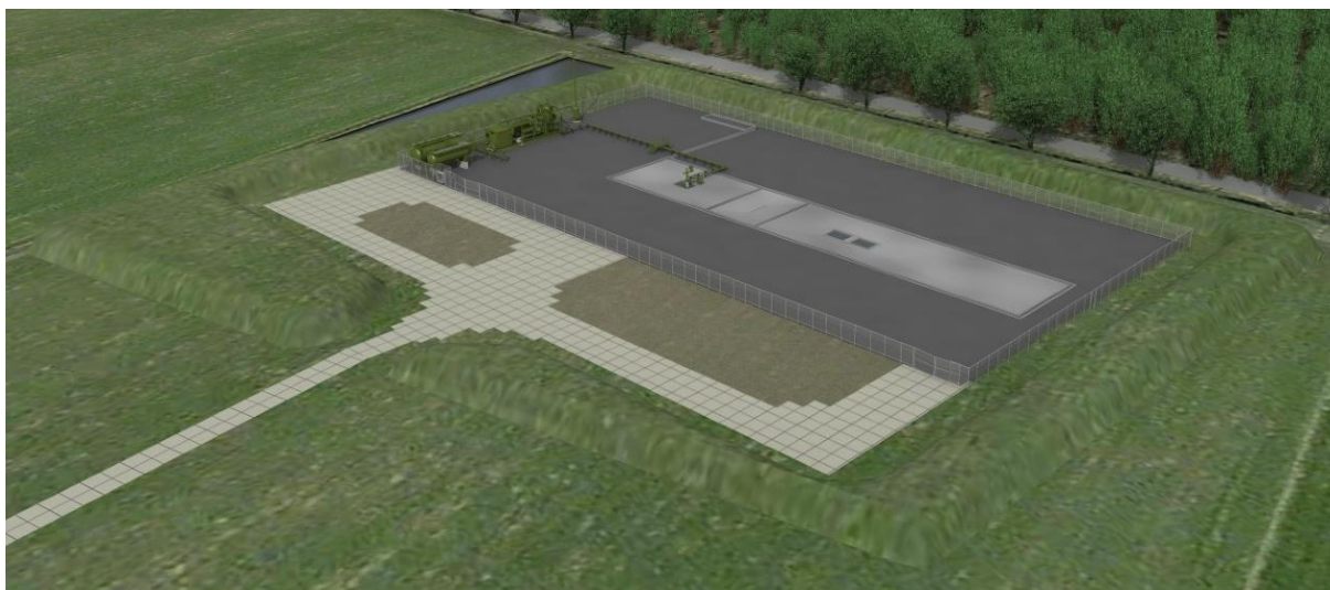
Figuur 2-3: Visualisatie van een mijnbouwlocatie met toegangsweg, omwalling, watergang, terreinverharding en gaswininstallatie.
