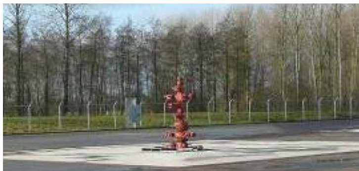
Figuur 2-6: Voorbeeld van een spuitkruis, mijnbouwlocatie De Hoeve.
