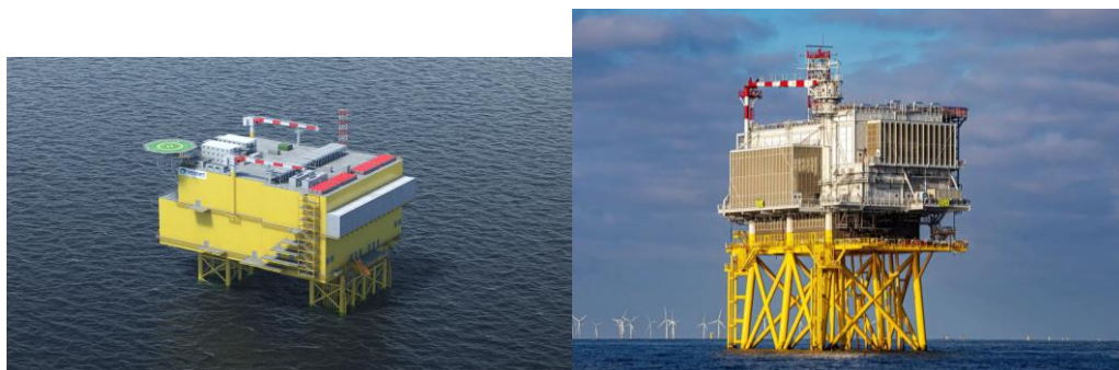
Afbeelding 3.2 Het platform op zee (links DC, rechts AC)
