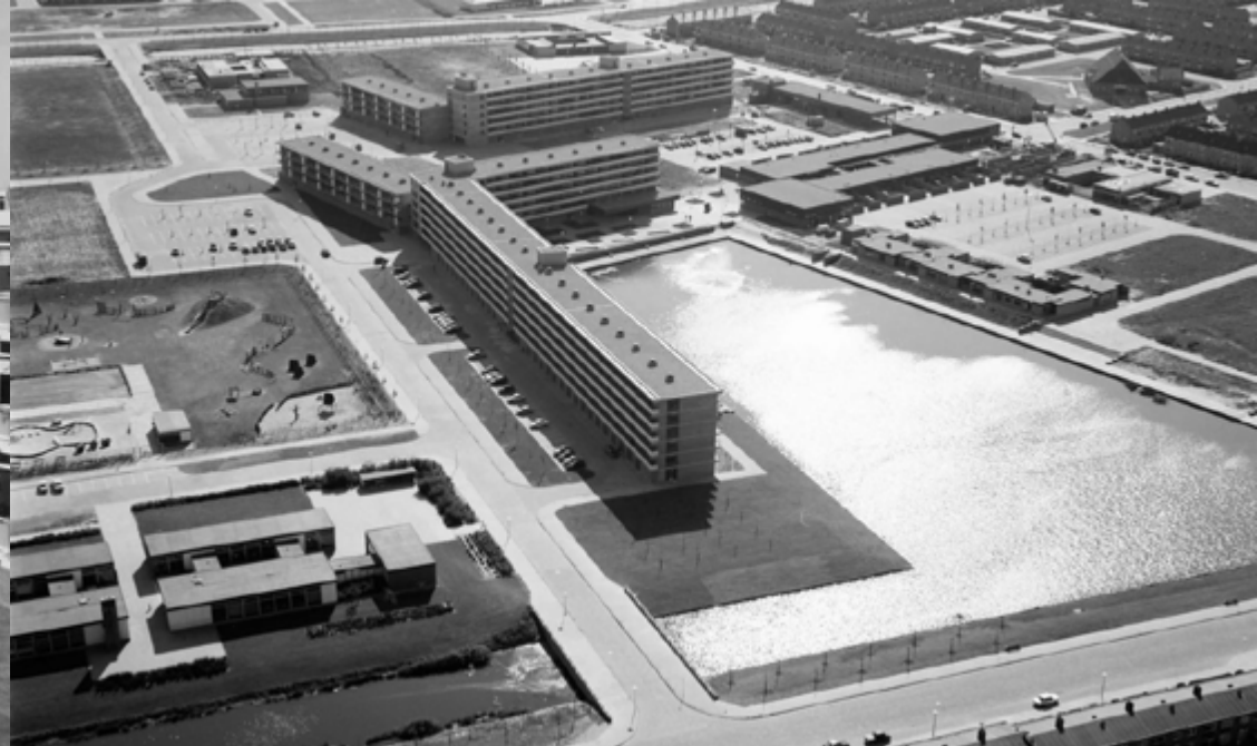
Het complex Heiligharn in het centrum van De Schooten, in 1971. Het complex is in 2020 gerenoveerd en opgetopt met een extra verdieping. (bron: Helderse Historische Vereniging)
