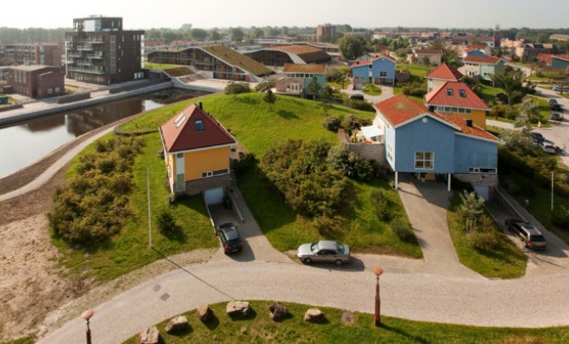
Duinpark woningen in Nieuw Den Helder op basis van een stedenbouwkundig plan van Ashok Balothra. (bron: BBHD architecten)
