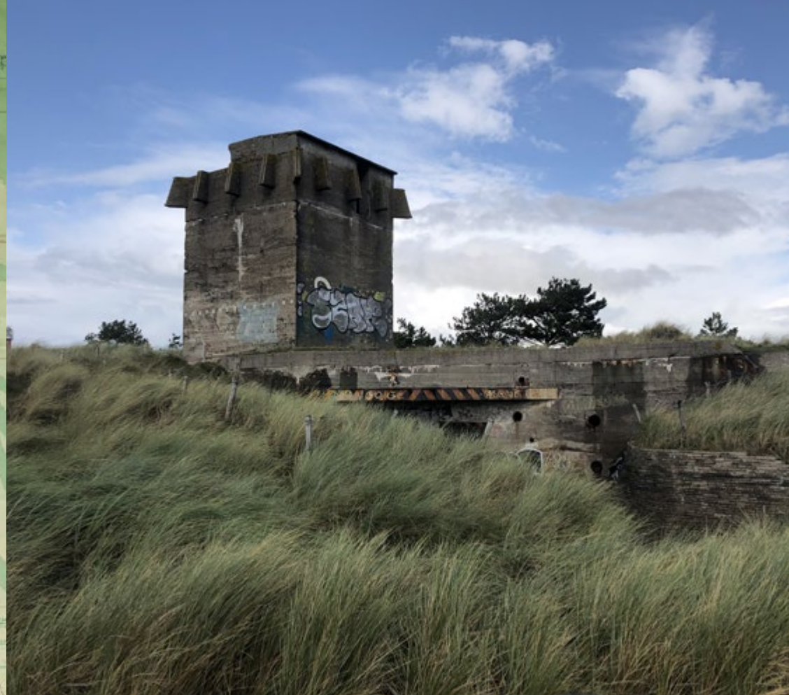
In de Grafelijkheidsduinen ligt een stelsel van bunkers. De bekendste is de kroontjesbunker, die vanwege de vorm zo wordt genoemd. De bunker is een zeldzaam type. (bron: Lisa Timmerman)
