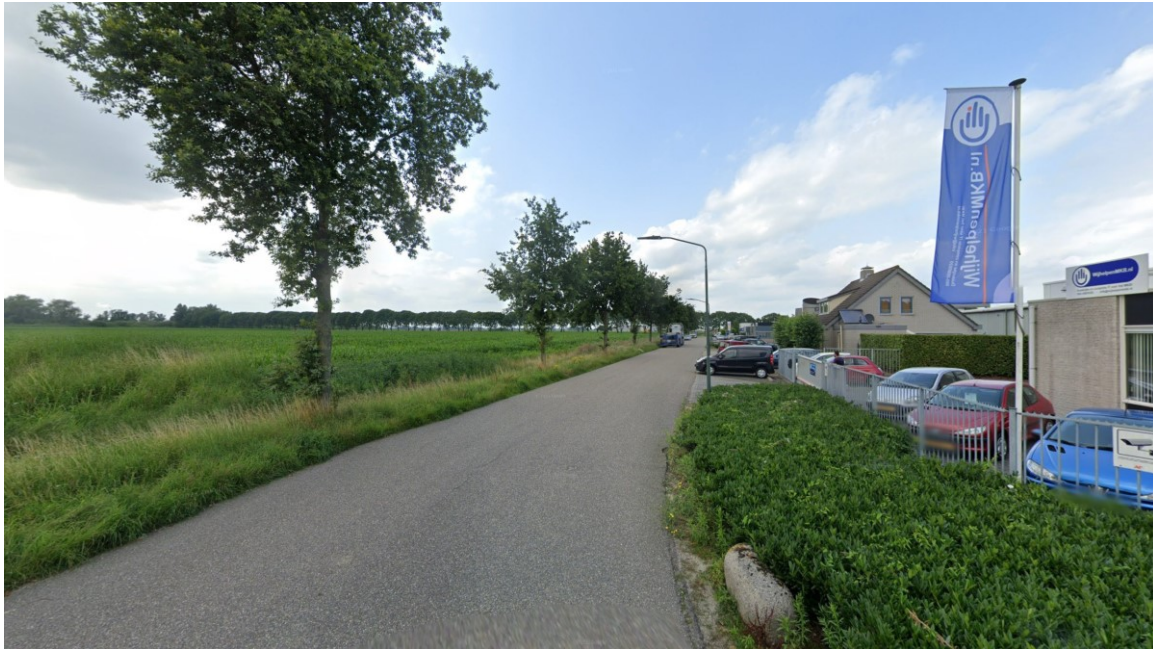
Afbeelding XIII.25 Overzicht van de westelijke plaatsingszone van alternatief Zon Besloten, zicht vanaf de Blokenweg.
