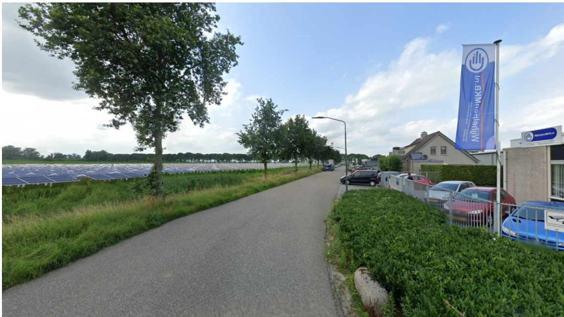
Afbeelding XIII.26 Overzicht van de westelijke plaatsingszone van alternatief Zon Besloten na installatie van een zonnenveld
