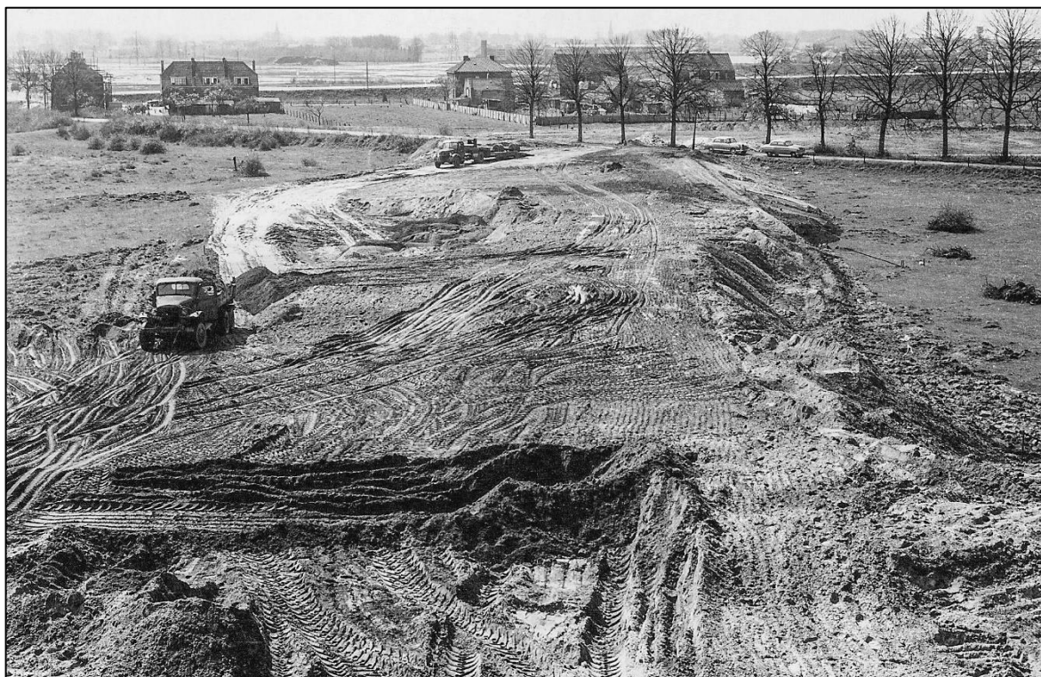
Afbeelding 20. Aanleg bouwterrein in 1959. Zo gezien werd het terrein opgehoogd op het oorspronkelijke maaiveld.
