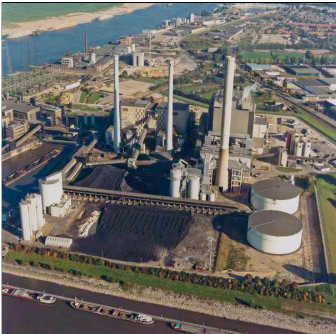
Afbeelding 26: Luchtfoto uit 1986 van het zuidelijk deel van het terrein met de CG11,12 en 13 samen aanwezig. Links voorbij de haven ook de nog aanwezige CG1 centrale (foto vanaf het westen genomen). Vooraan is het kolenpark duidelijk zichtbaar met rechts de zware olietanks. (bron: archief Engie-centrale)
